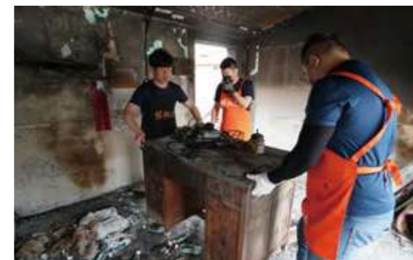
羅賴把志工幫助屏東火災受災戶修繕房屋。
